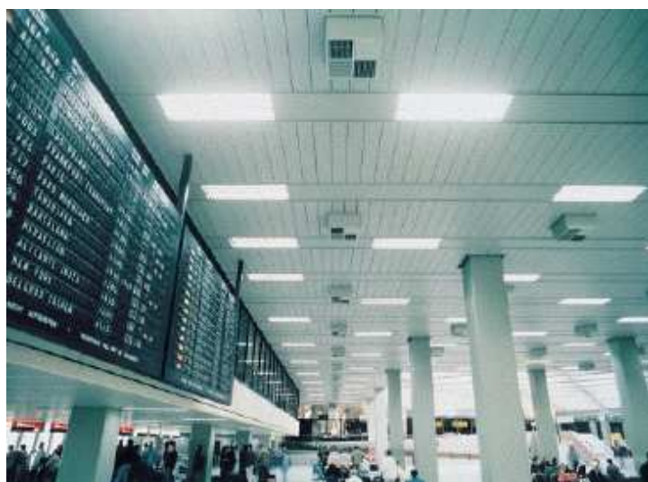
Χώρος με χρήση λαμπτήρων φθορισμού
